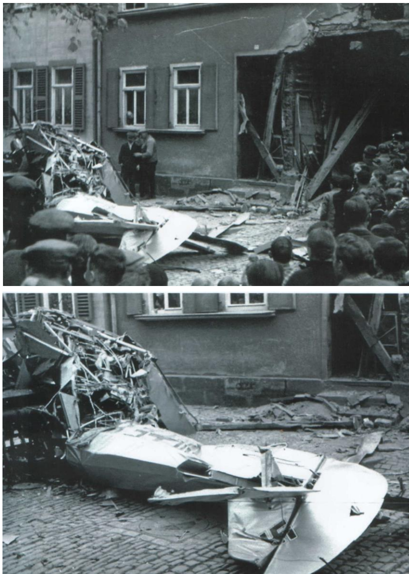
Abb. 4: Bilder des Unglücks - mit dem völlig zerstörten Flugzeug und den schweren Schäden an den Herrnschmiede-Gebäuden am 10.10.1939.
