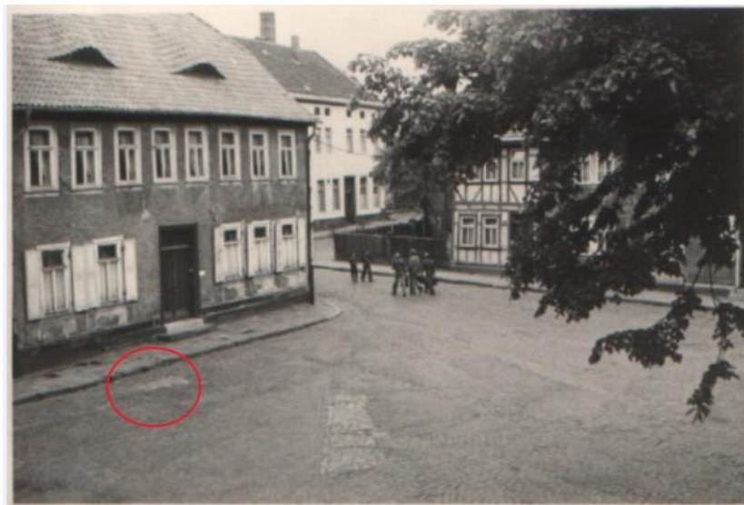
Abb. 7: Heiligenstadt Lindenallee 37, ehemaliges Diegmansches Haus, heute Pax Bank, davor befand sich bis Ende der 1960er Jahre ein kleines Trafo-Blech-Häuschen (rote Markierung, dort, wo sich die helleren Pflastersteine abzeichnen) mit einem dachfirsthohen Gittermast, an dem die Freiluft-Stromdrähte befestigt waren, von denen je zwei zu jedem Wohnhaus führten und dort an Isolatoren befestigt waren. In den noch darüber verlegten Telefondrähten verding sich Fahrwerk oder Tragfläche des Flugzeugs und führte zum Absturz. Quelle: FamilienA Heinevetter, Heiligenstadt.
