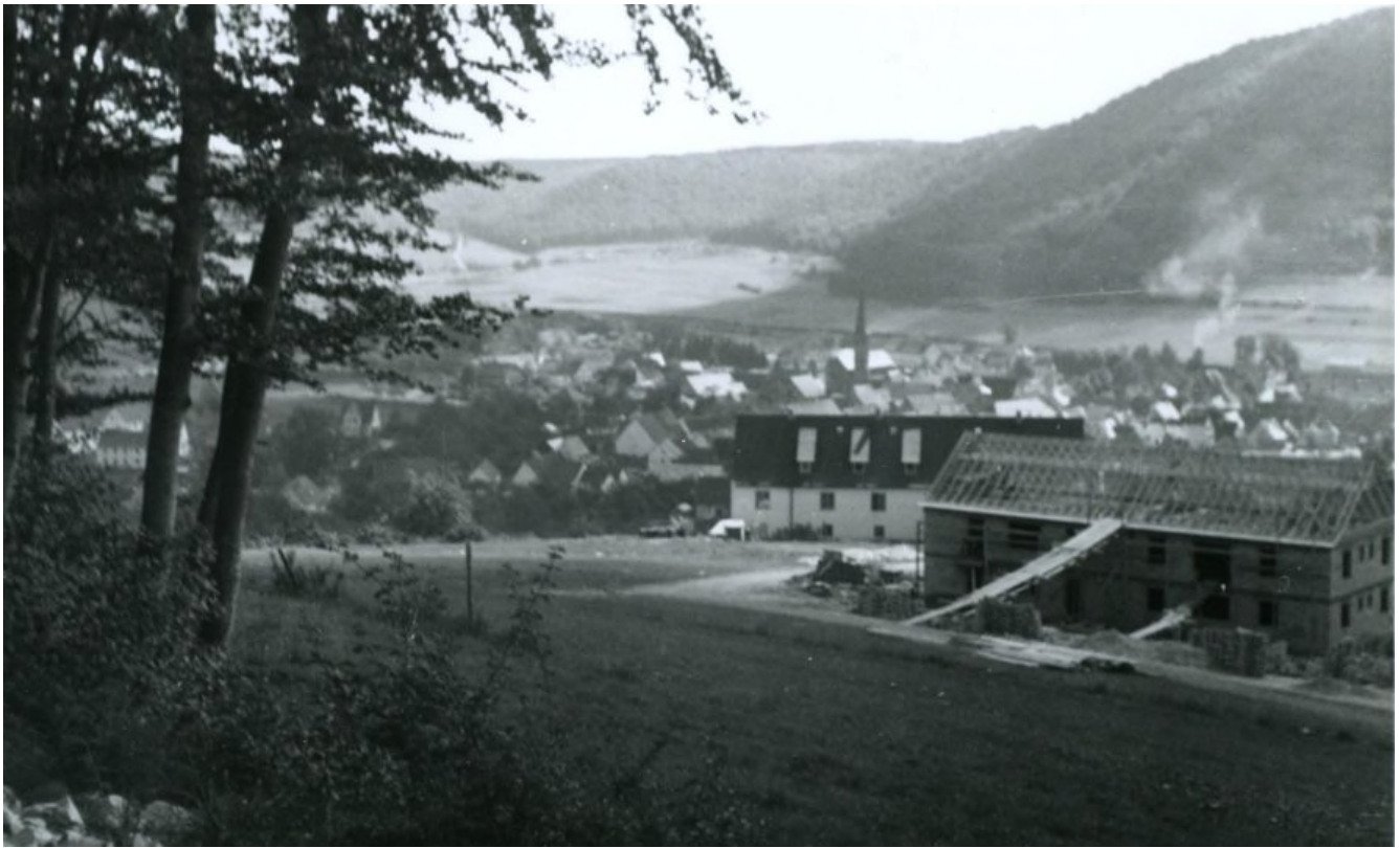
HJ-Heim, Männerwohnheim, Progymnasium, Sonnenbergschule und Gebäude Sonnenbergstr. 2 im Bau.
